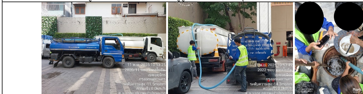
รูปที่ ๗.8 การเก็บไขมันจากถังดักไขมันของระบบบำบัดน้ำเสีย
