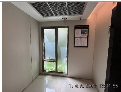
รูปที่ ผ7.42 ช่องระบายอากาศบริเวณห้องโถงน้ำลิฟต์ดับเพลิง
